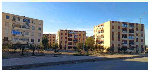
Figura 16 – Bloc de apartamente din Algeria (orașul N’gaous). Fotografie realizată la 01.04.2024.
