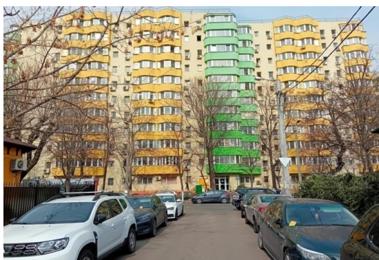
Figura 1: Bloc de apartamente din România (orașul Lacul Tei – București. Fotografie realizată la: 22/02/2024).
