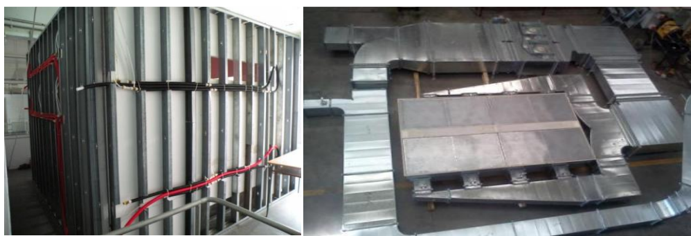
Figure 6: Construcția camerei climatice și a sistemului de ventilare
