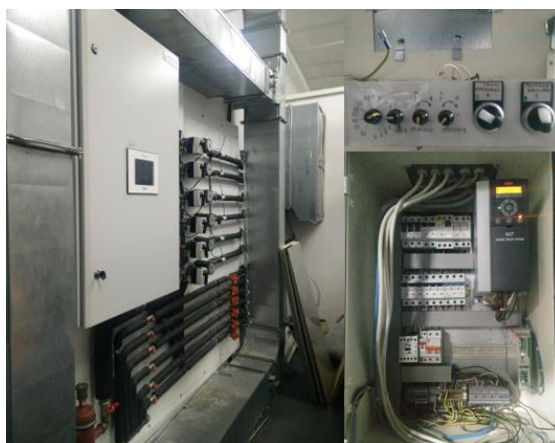
Figure 11: Circuitele hidraulice ale camerei climatice și circuitul de comandă a sistemului de ventilare
