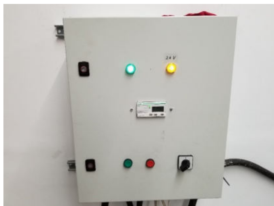
Fig. 10 (Figura 4.3): Dulapul electric pentru comanda standului și a motorului electric.
