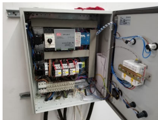
Fig. 10 (Figura 4.3): Dulapul electric pentru comanda standului și a motorului electric.
