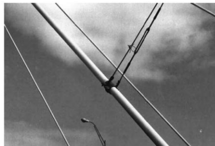
Figura II-11 – Cabluri transversale de rigidizare a hobanelor (Caetano)
