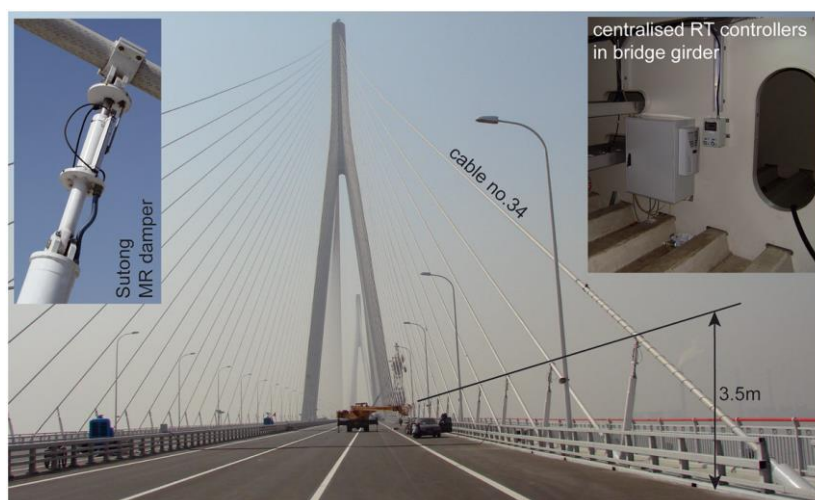
Figura 33 – Amortizori pe podul Sutong, China
