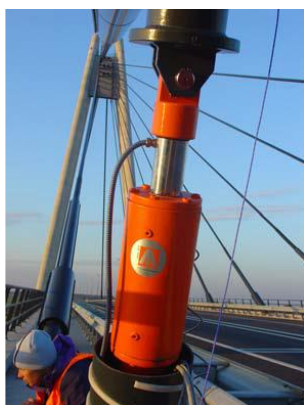
Figura 27 - Poză amrtizor magneto-reologic Catalog Maurer
