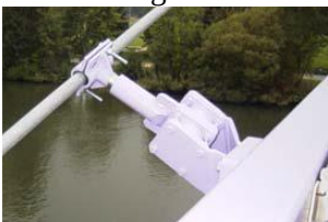
Figura 20 poză amortizor elastic extern Catalog Maurer
