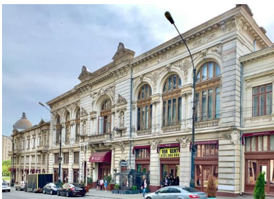
Fig. 3.2.1. Clădiri cu pereți structurali de zidărie portantă
