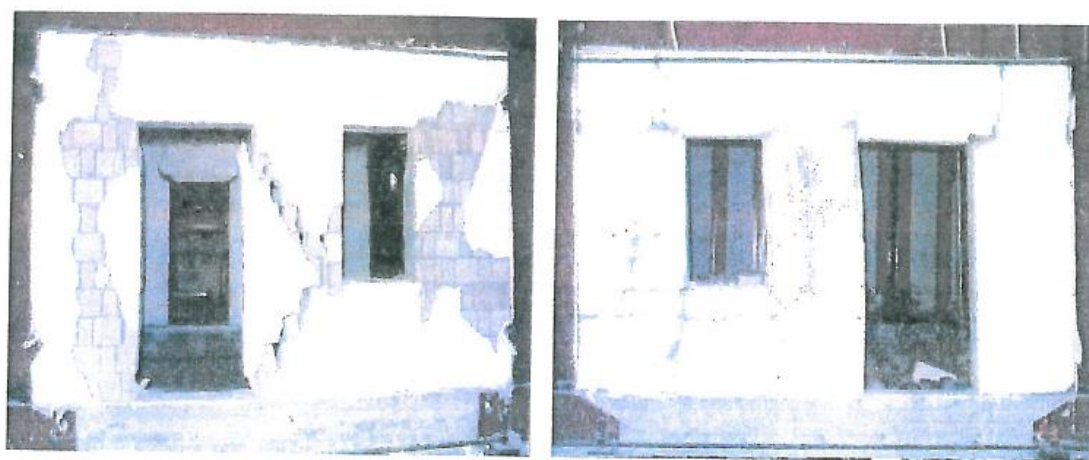
Fig. 2.3.2. Panoul de zidărie simplă în stânga și panoul de zidărie armată în dreapta, la sfârșitul încercării [4]
