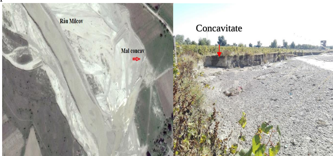
Fig.3.1. Aspectul eroziunii de mal stâng, râu Milcov, loc. Odobești, jud. Vrancea
