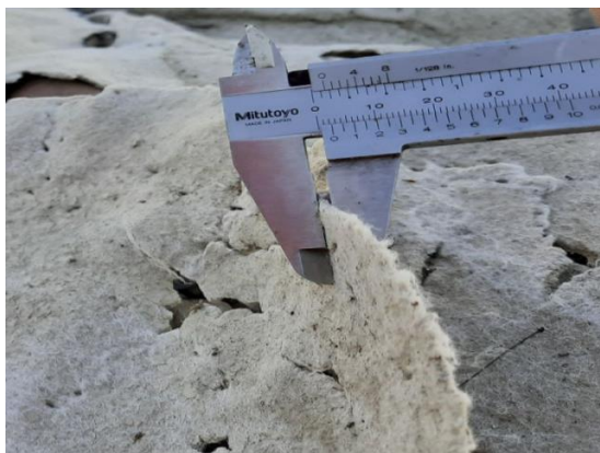
Fig.7.5. Geotextil degradat de raze U.V
