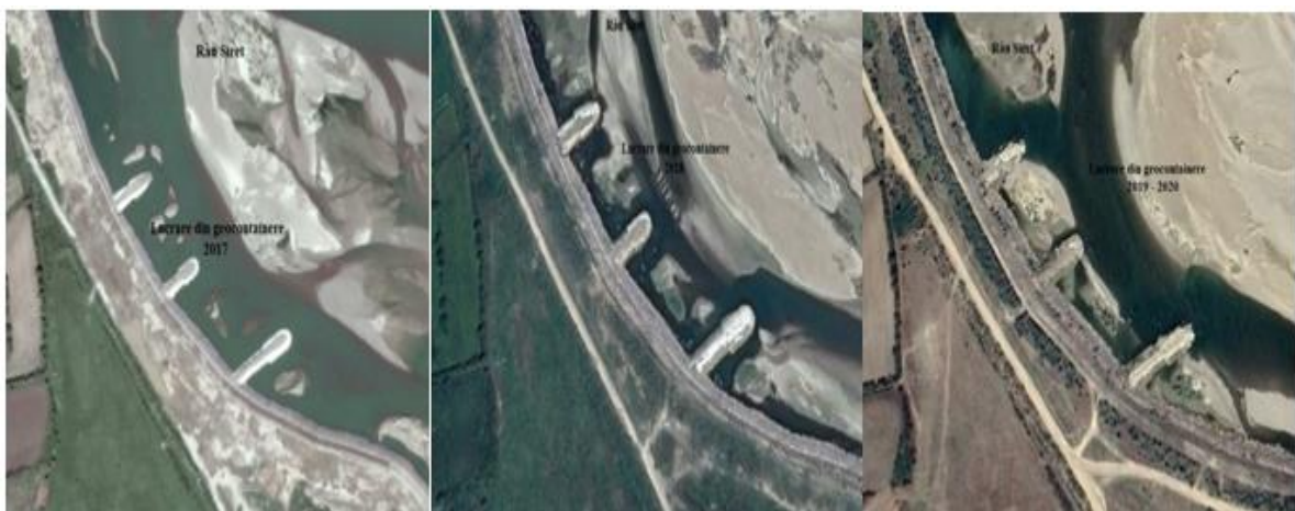
Fig.9.12. Dezvoltarea vegetației pe lucrările de geocontainere
