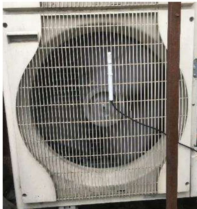
Figura 53 Senzorul de temperatura pe intrarea in vaporizator
