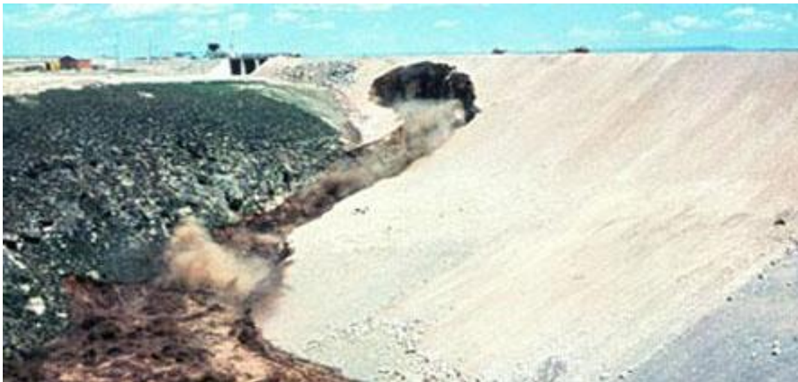
Figura 5. Fotografie a barajului Teton: în apropierea amiezii, scurgerea s-a extins și mai mult și s-a lărgit sub creastă [7].
