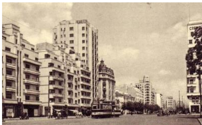
Fig. 11: Blocul Carlton, înainte de cutremurul din 1940 [7]
