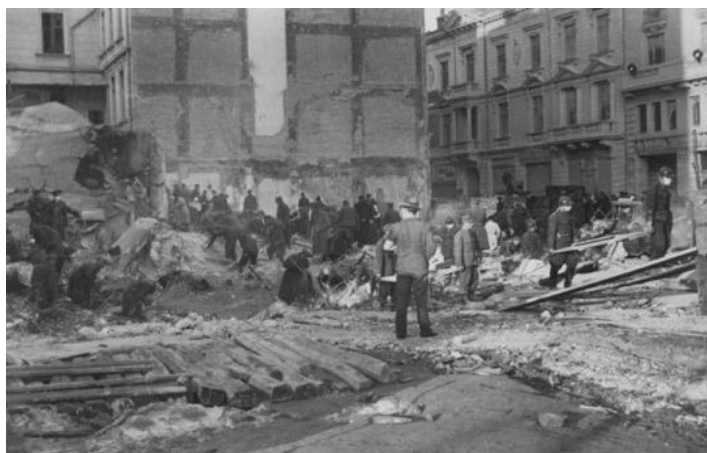
Fig. 12: Ruinele după prăbușirea blocului Carlton [11]
