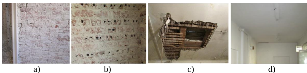
Figură 6.19 – a) pereți portanți realizați din cărămidă ceramică plină presată; b) inserții/completări cu zidărie realizată în stil american, din cărămizi ceramice cu goluri orizontale; c), d) planșeu cu structură din lemn; [122]
