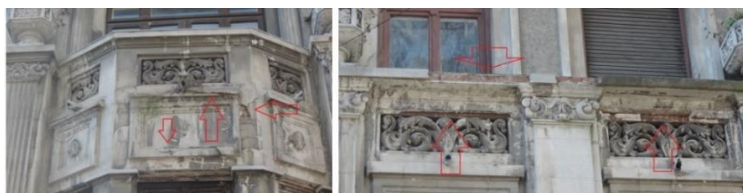
Figură 6.24 – a), b) Degradări ale tencuielilor fațadei principale [122]
