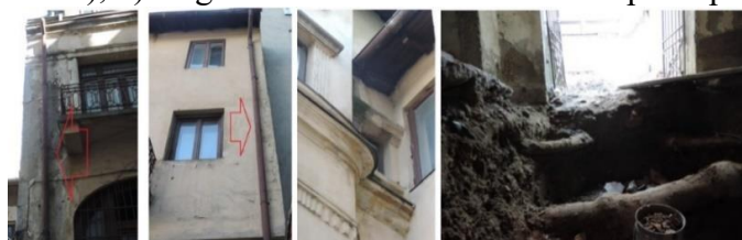
Figură 6.24 – a), b) Degradări ale tencuielilor fațadei principale [122]
