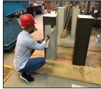
b) Applying two coats of MapeWrap Primer 1.
