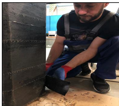
a) Învelirea fâșiilor de CFRP.
