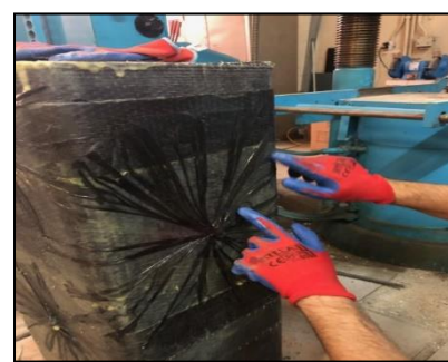
f) Aplicarea unui strat de MapeWrap 31 peste substrat, apoi lărgirea tuturor fibrelor.
