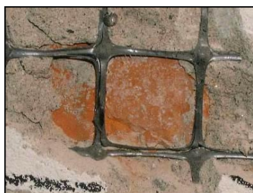
Figura 7.8. Degradare grile
