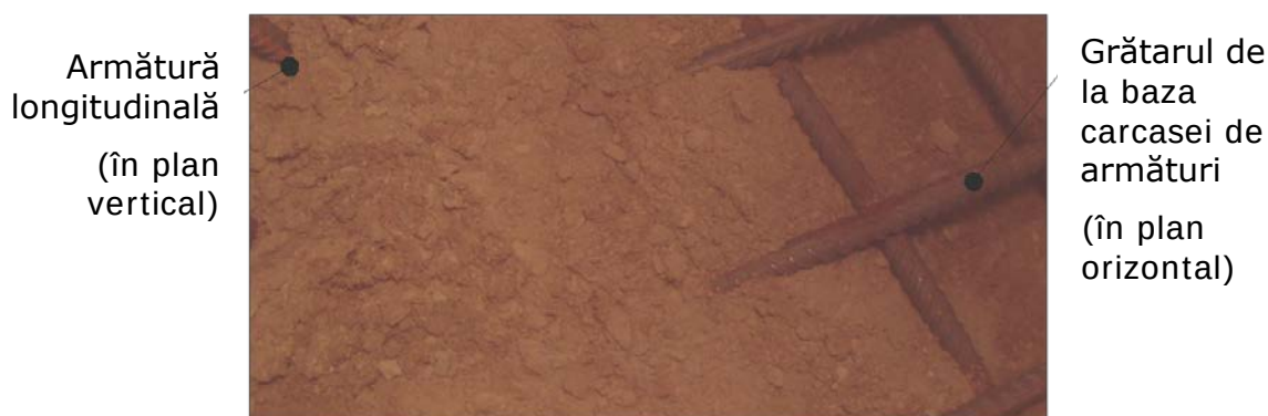
Figura 23. Baza pilotului după instalarea carcasei de armătură a pilotului
