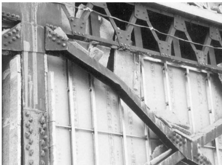
Fig. 1. 23 Flambajul diagonalei cu secțiune „I” în planul cadrului, în urma cutremurului de la Kobe 1995 [3]
