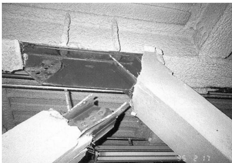
Fig. 1. 27 Cedarea prinderii diagonalei la un cadru contravântuit în sistem „V inversat”, în urma cutremurului de la Kobe 1995 [3]
