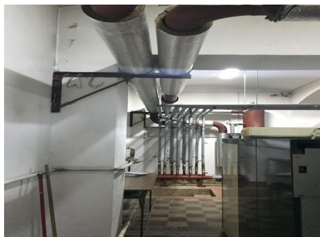
Fig.38 Soluții de protecție împotriva zgomotului în instalația de cazane
