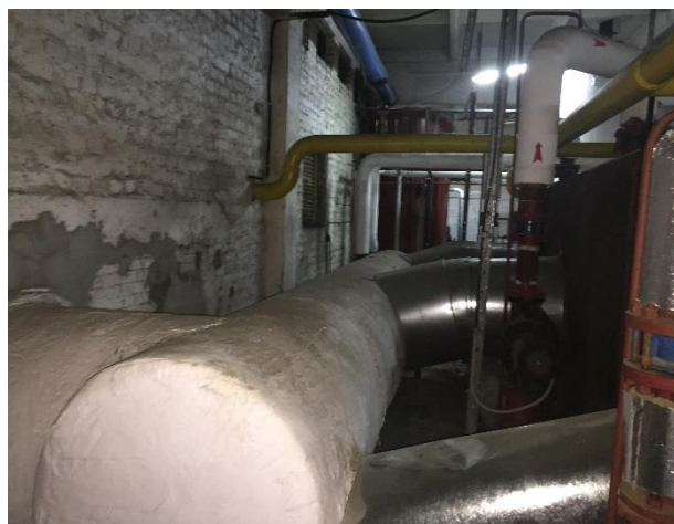
Fig. 9 Soluţii de protecţie la zgomot în centrala termica
