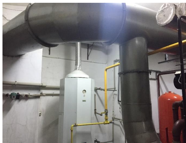
Fig.38 Soluții de protecție împotriva zgomotului în instalația de cazane
