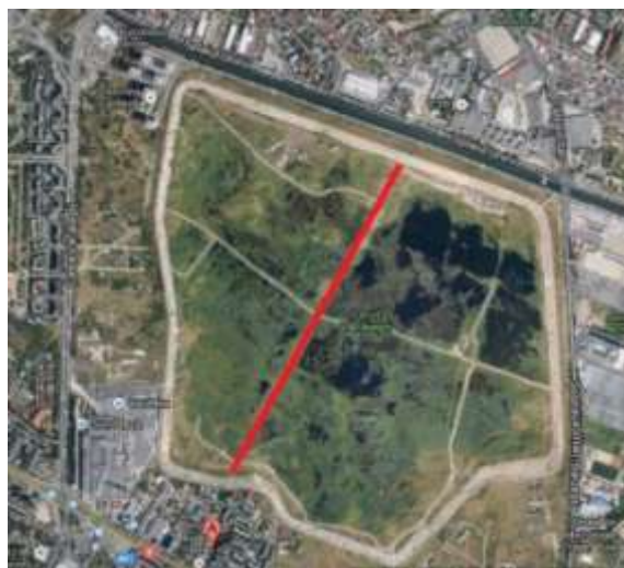
Figura 17. Traseul vechiului colector A3 în albia Lacului Văcărești – vedere de sus (swww.google.ro/maps)
