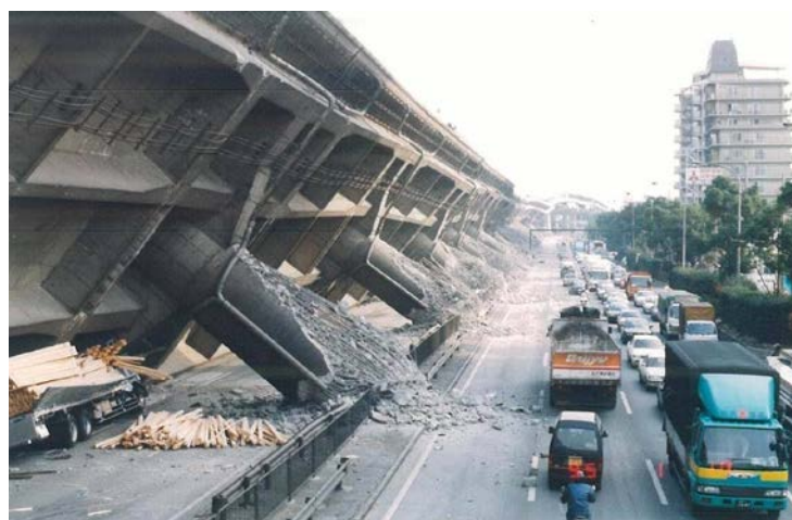
Fig. 1 Cedarea podului nr.3 de pe autostrada Hanshin (Kobe 1995)
