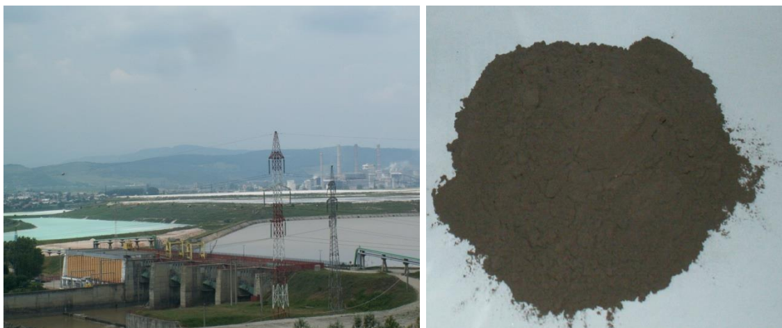
Figura 25. Bazin de decantare al uzinelor sodice și cenușa captată
