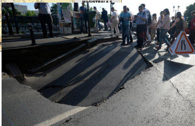
Figura 8.16. Surpare în zona stației de metrou Eroilor (Sursa: www.Adevărul.ro )
