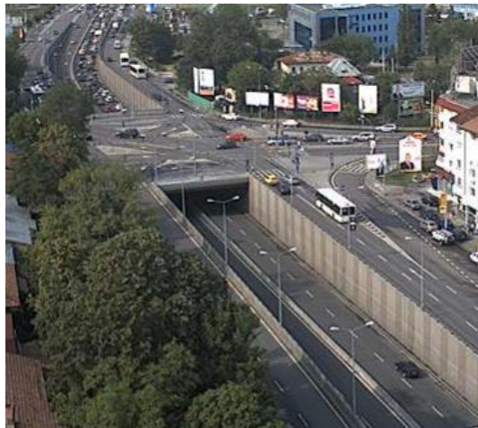
Fig. 23. Băneasa passage (tunnel)
