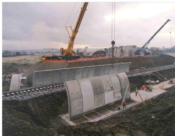
Fig. 4. Tunnel type „ABM” [4]
