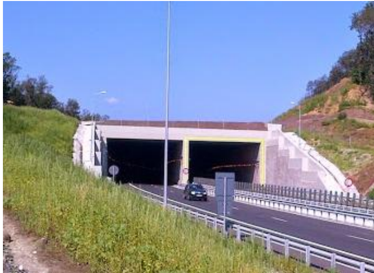
Fig. 35. Sacel tunnel, A1, Sibiu – Orăștie [9]
