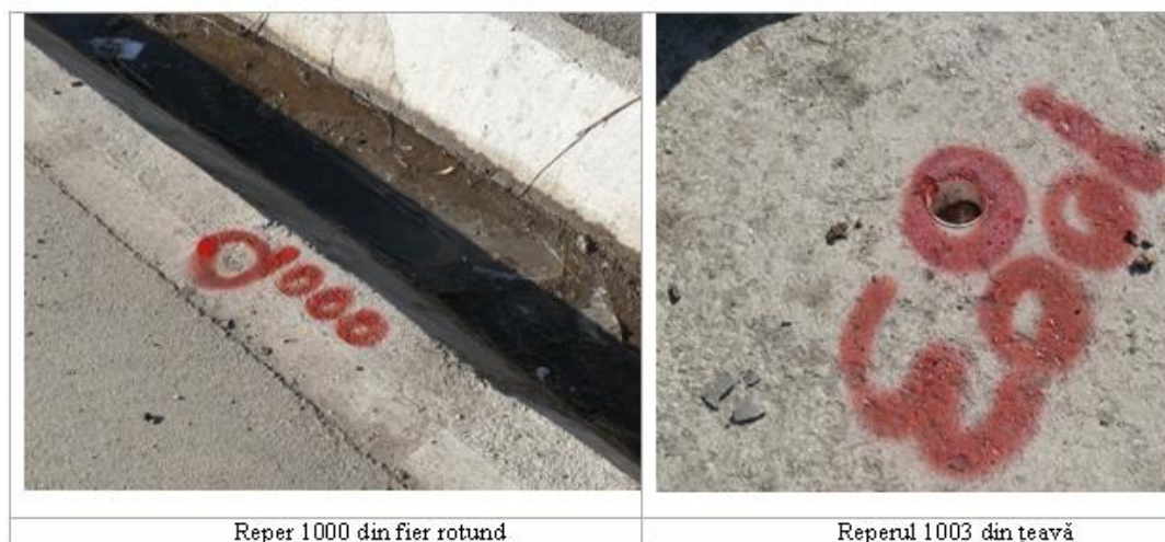
Fig.4. 15 Marcarea pe teren a reperilor de monitorizare a fenomenului de subsidență
