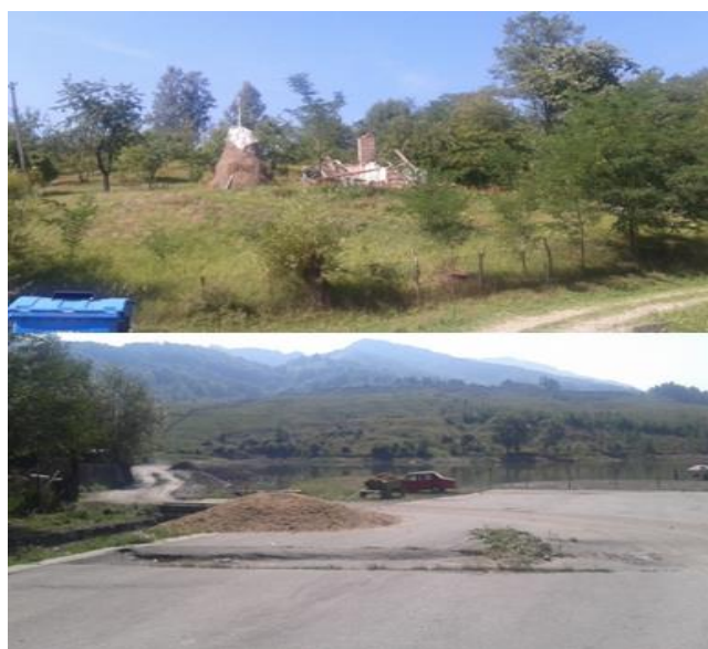
Fig.4. 3 Efecte negative ale fenomenului de subsidență datorat exploatării de zăcăminte stratiforme, zona Lonea-Defor, localitatea Petrila, județul Hunedoara, România
