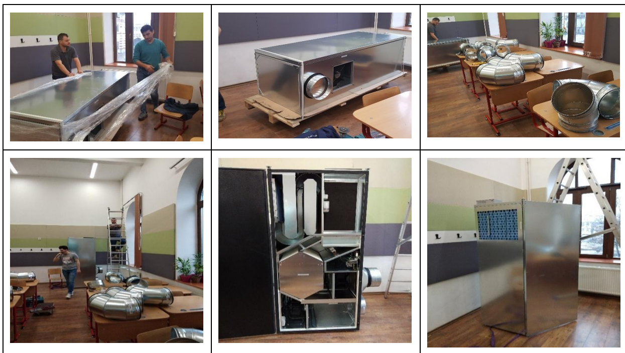
Fig.6 Amplasarea și montarea recuperatorului de căldură și a tubulaturilor de ventilație
