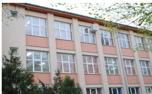
Fig. Vedere exterioară sistem de ventilare
