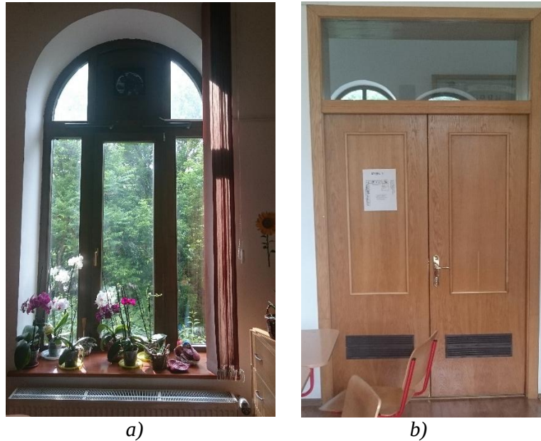
Fig. 28 – a) Photo of the actual window, b) Photo of the actual door
