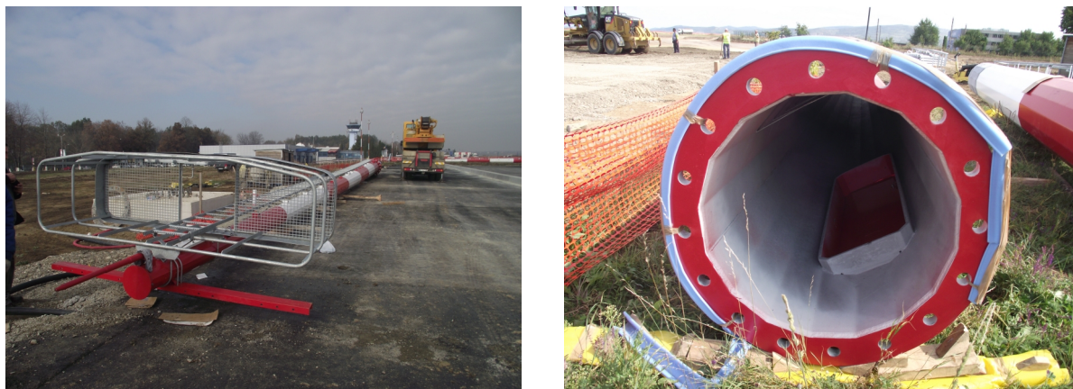
Fig. 2.4 Poze din timpul montajului pilonilor de iluminat de la Aeroportul Iași: a) montajul la sol al tronsoanelor, al scării, platformei de lucru, paratrăsnetului și al structurii reflectoarelor; b) prezentarea tronsonului 1 cu placă de bază și ușă de vizitare cabluri.
