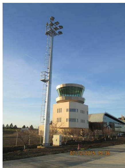
Fig. 2.2 a) Pilon de iluminat h=20\text{m} cu coroană mobilă de reflectoare, Aeroport Internațional Oradea; b) Pilon de iluminat h=18\text{m} cu bară fixă de reflectoare și scară acces, Aeroport Internațional Suceava, 2015.
