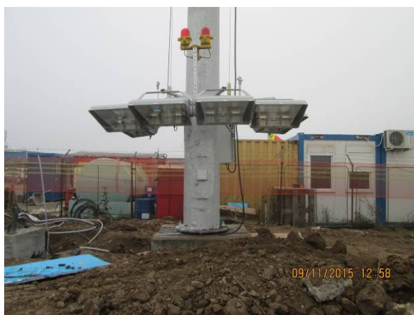
Fig. 2.2 a) Pilon de iluminat h=20\text{m} cu coroană mobilă de reflectoare, Aeroport Internațional Oradea; b) Pilon de iluminat h=18\text{m} cu bară fixă de reflectoare și scară acces, Aeroport Internațional Suceava, 2015.
