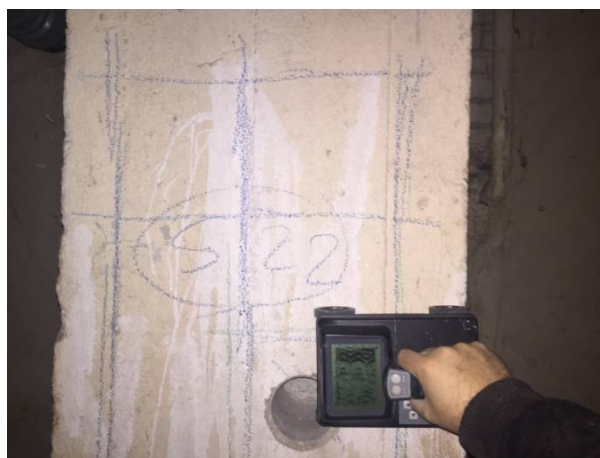
fig 3.6.5 Pozitionare carotare stalp beton -evitare armaturi stalpi
