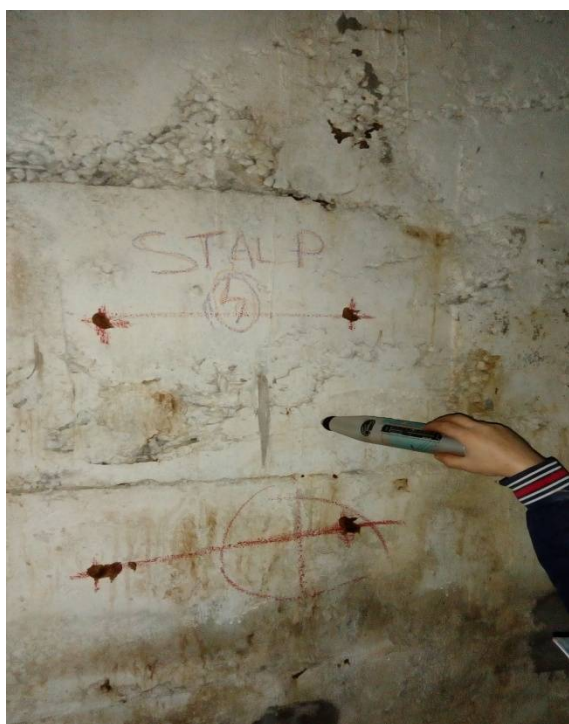
fig .4.1.2.degradari bazin inot - protectie necorespunzatoare elemente beton armat in contact cu vaporii de clor
