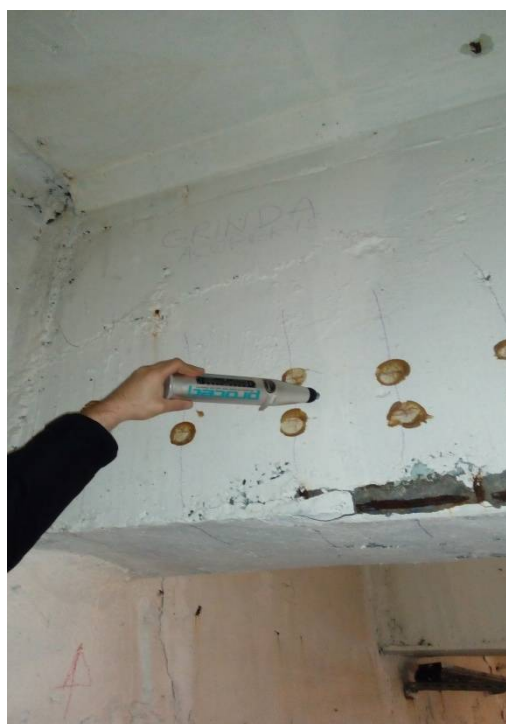
fig .4.1.2.degradari bazin inot - protectie necorespunzatoare elemente beton armat in contact cu vaporii de clor
