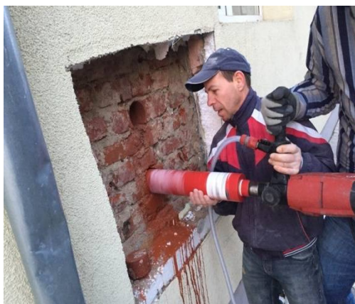
fig.5.3.2.12 a) carotare perete zidarie subsol uscata .b) carote din pereti diferiti
