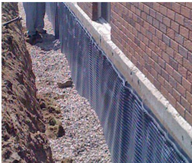
fig.4.3.3 .perete exterior cladire interbelica reabilitata la nivelul hidroizolatiei verticale pereti subsol cu membrane
