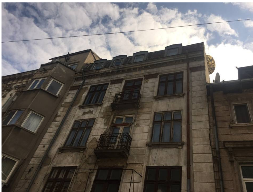
fig.2.9.3 Defect de conformare cladirea CALEA MOSILOR -cladiri realizate fara rost,în sir.
