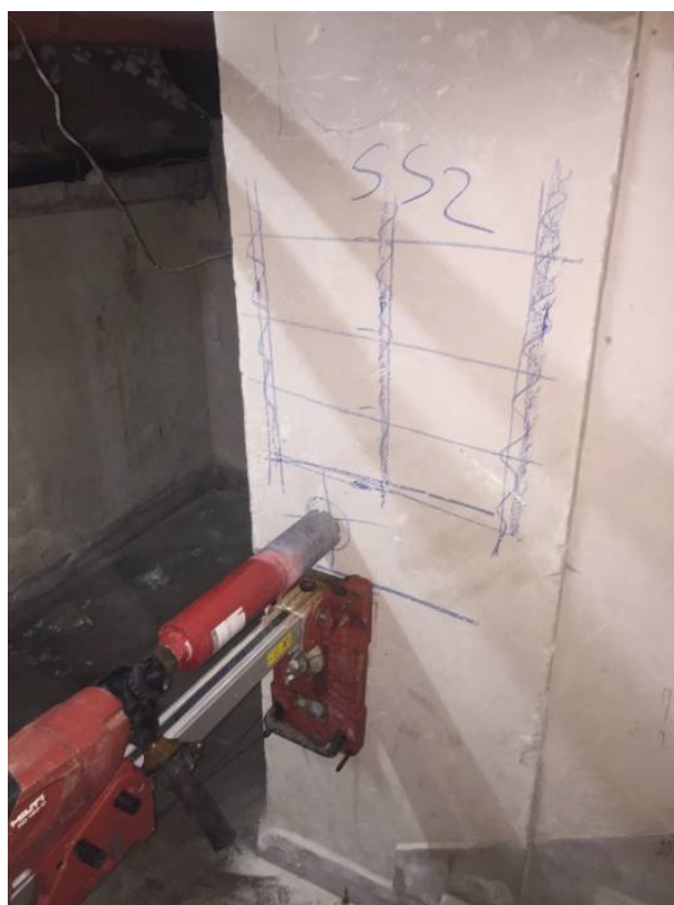
fig 3.6.3 carotare stalp beton -NUMAI DUPA TRASARE PAHOMETRICA
