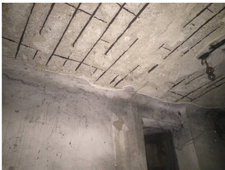
fig 6.2.2.11 -teste imagistica 3D efectuate la cldire S+P+3E ,str GOLESCU,BUCURESTI -au fost determinate si zone degradate dupa semnalul dispersat al armaturii-imagine dupa decopertare
