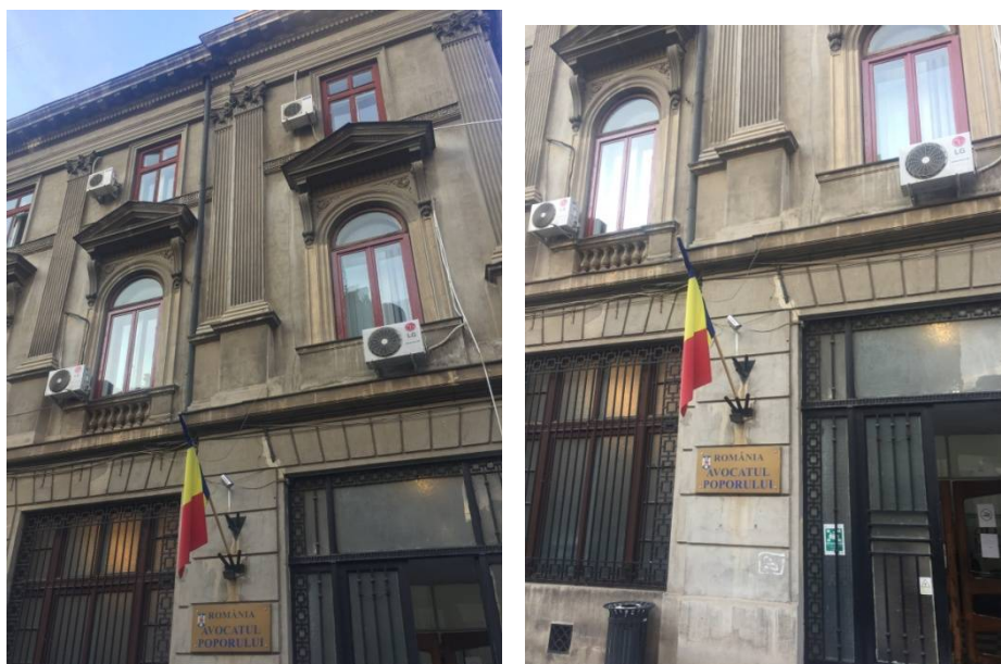
fig 6.2.3.8.-cladire sediu administrativ 1930 cu pereti grosi zidarie : 80 cm zidarie -initial presupusa cladire integral de zidarie
