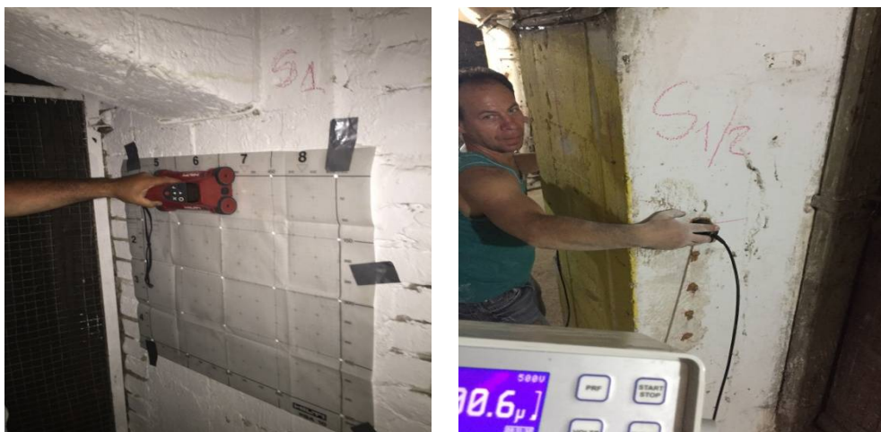
fig.2.16-incercare nedistructiva stalp beton ,cladirea 1930, CALEA VICTORIEI
