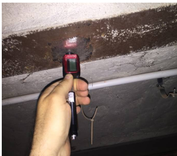
fig.4.2.4 .Cladire 1930 cu zidarie subsol+profile metalice planseu subsol afectate de umezeala pe termen lung :
