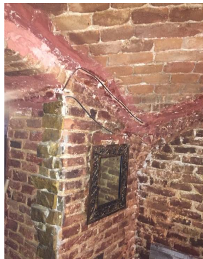
fig .4.1.1.cladire SIBIU afectata de umezeala subsol-bolti de zidarie
