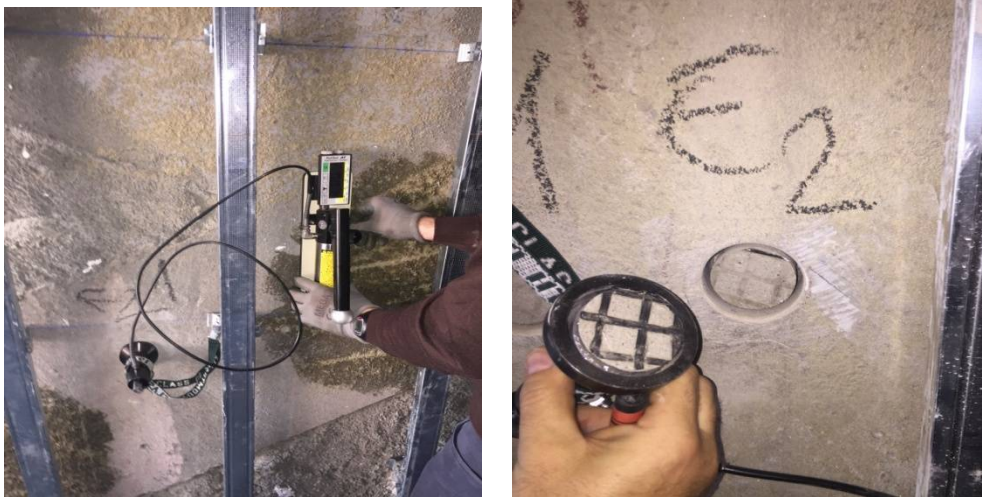
fig.5.3.2.16 incercare cu presa in situ la intindere pe carote de consolidare cu fibra de sticla si mortare speciale pe pereti de zidarie
