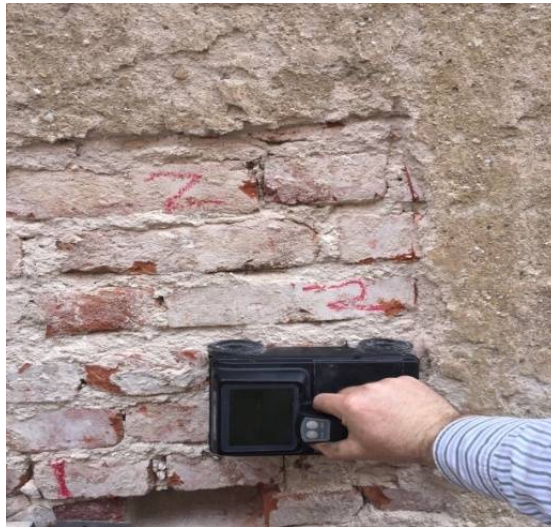
fig 5.3.2.11 .a)Pregatire fata 1 perete cu RADARUL
