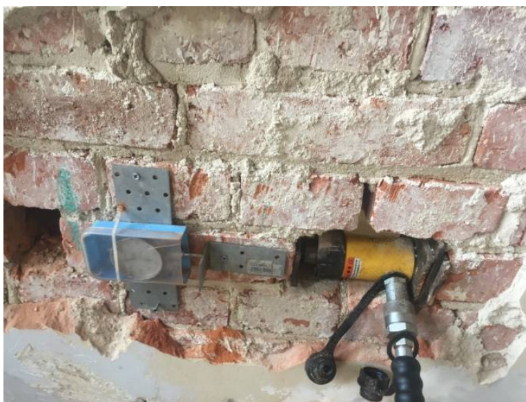
fig.2.12 inspectie vizuala perete zidarie parter -cu ocazia testelor la mortar tip:shove test
