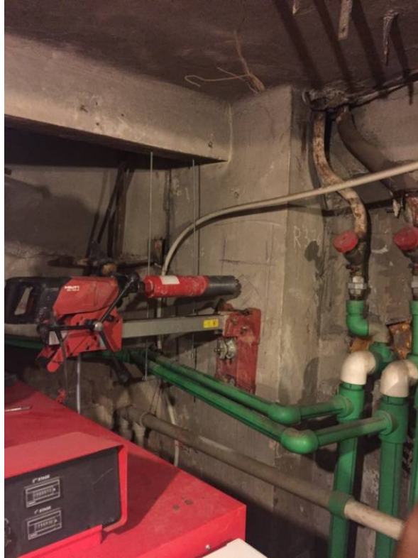
fig 3.6.1 carotare stalp beton in zone greu accesibile
