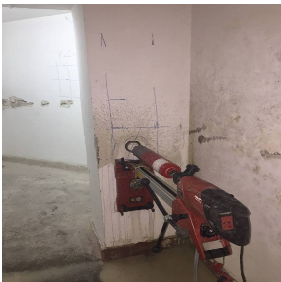
fig 3.6.4 carotare stalp beton -pozitie stabilita de expert-pentru a nu fii influentata rezistenta elementului structural
