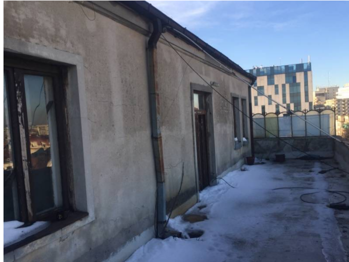
fig.2.9.1 Discontinuitate cladire CALEA VICTORIE retrageri -la ultimul etaj Efectele negative ale traseelor intrerupte de rigiditate se concentrează la etajele flexibile .
