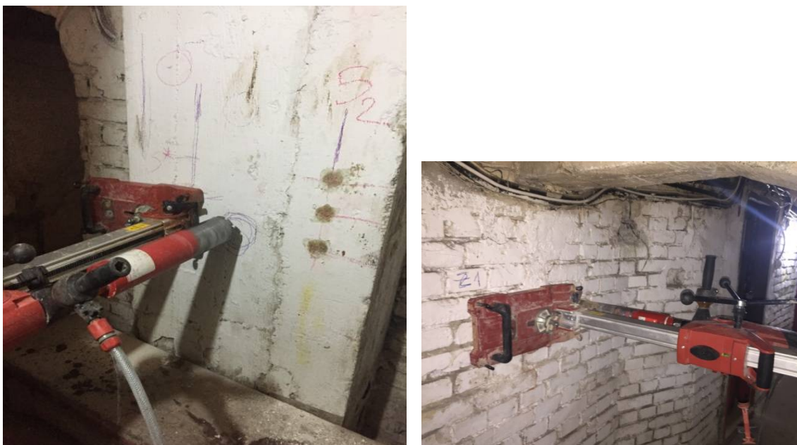
fig.2.15-incercare distructiva stalp beton- carotare zidarie ,cladirea 1930 ,CALEA VICTORIEI
