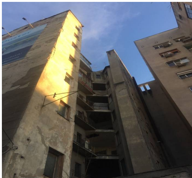
fig.2.9.1 Discontinuitate cladire CALEA VICTORIE retrageri -la ultimul etaj Efectele negative ale traseelor intrerupte de rigiditate se concentrează la etajele flexibile .
