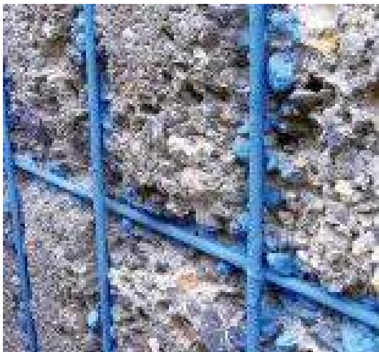
fig.4.3.2 .perete exterior cladire interbelica reabilitat la nivelul armaturilor cu mapefer-MAPEI pentru oprirea procesului de coroziune
