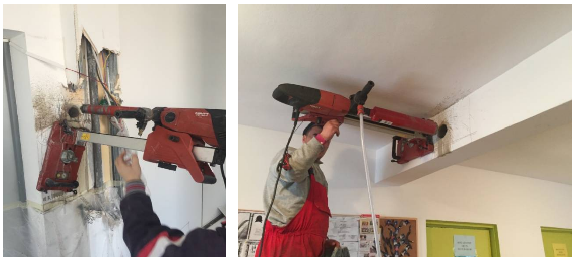
fig.5.18 carotare stalp -dupa pahometrie ; carotare grinda -dupa pahometrie
