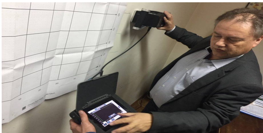
fig. 6.2.4.6. . -teste imagistica PULSE-ECHO efectuate la UTCB-catedra de CIVILE,pe un PERETE B.A. impreune cu specialistul PROCEQ,LUBOS MISAK IN DATA DE 17.04.2018-INCERCAREA ESTE FACUTA FARA DECOPERTAREA PERETELUI
