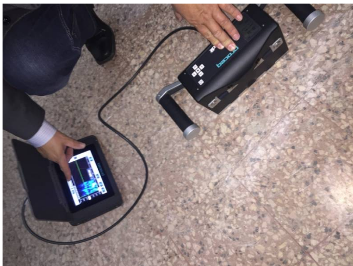
fig. 6.2.4.9 . . -teste imagistica PULSE-ECHO efectuate la UTCB-LABORATOR DE MATERIALE pe un PLANSEU SUBSOL impreune cu specialistul PROCEQ,LUBOS MISAK IN DATA DE 17.04.2018-DETERMINARE GROSIME = 13 CM
