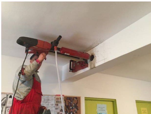
fig 3.6.2 carotare stalp beton in zone greu accesibile 2 -grinzi
