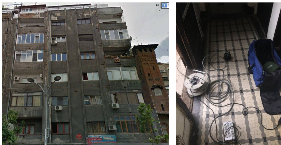
fig.2.7.rost seismic intre cladiri bd. BALCESCU -1938-incercari dinamice de evidentiare a acestuia
